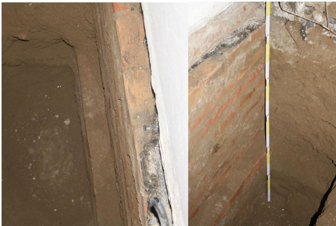
Figura 104: Sondaggio eseguito sul muro di spina.
