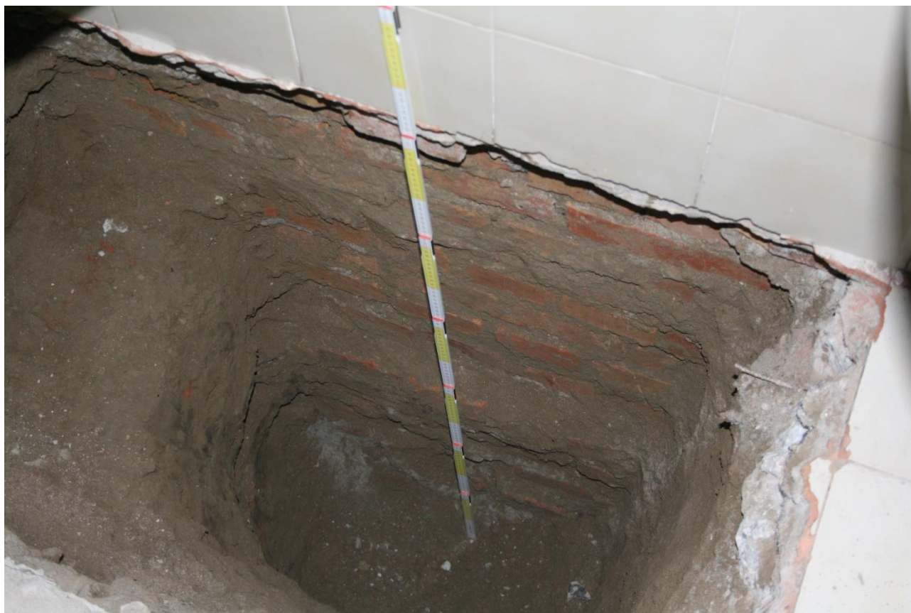
Figura 105: Sondaggio eseguito su di un muro a 2 teste.
